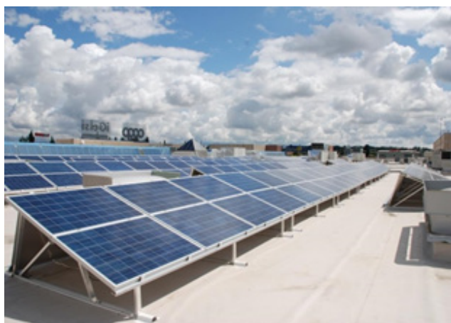
Sistema MCG 3.0 "posa inclinata 20 gradi"
