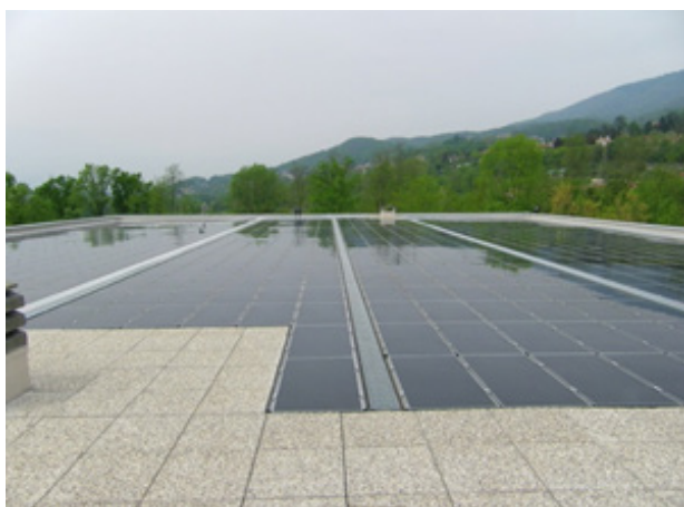
Sistema MCG 1.1Q "posa complanare"
