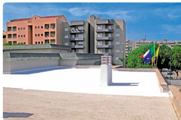
Figura 14. Vista della copertura con applicazione parziale della vernice Cool Roof
