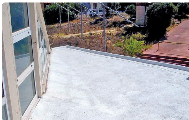
Figura 10. La copertura dopo l'applicazione del Cool Roof
