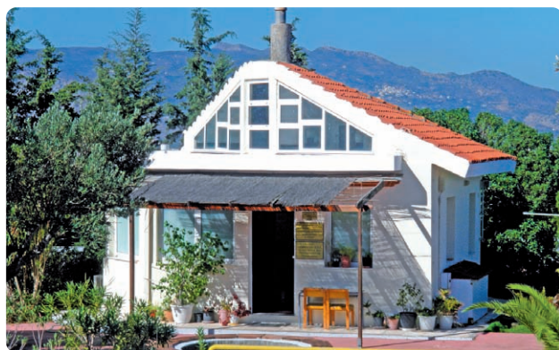
Figura 9. Edificio bioclimatico in prossimità di Iraklion
